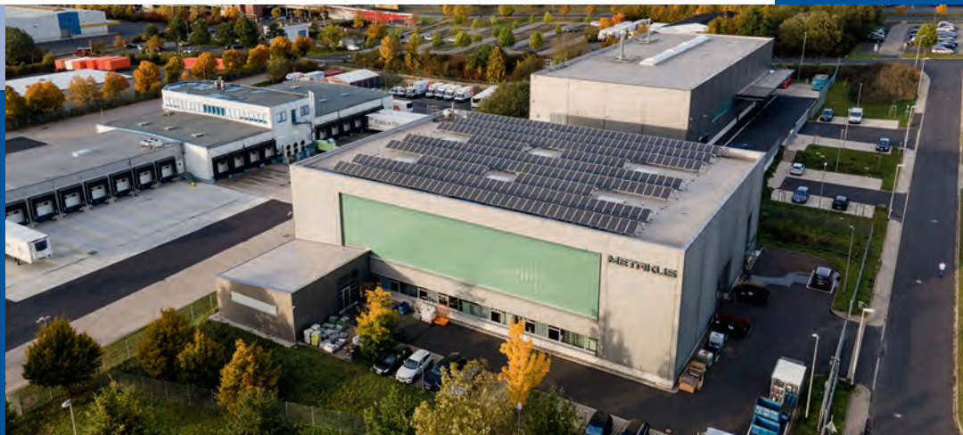
Abb. 1: Gießtechnikum Metakushalle des GTK am Standort Baunatal.
